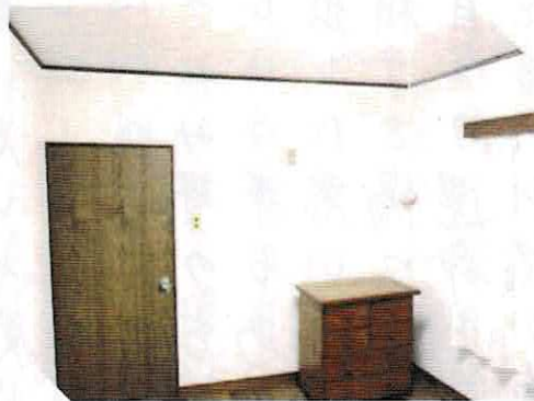
クロス張替完了
